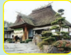
今ではめずらしくなくなったカヤぶき屋根の家
