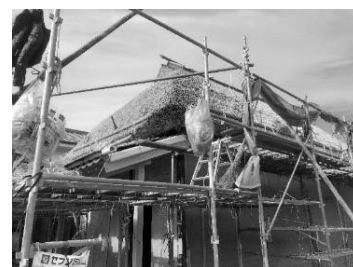
茅葺き屋根葺き替え現場
