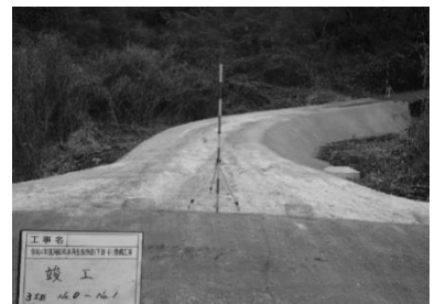
下野牧野における工事前後の様子
